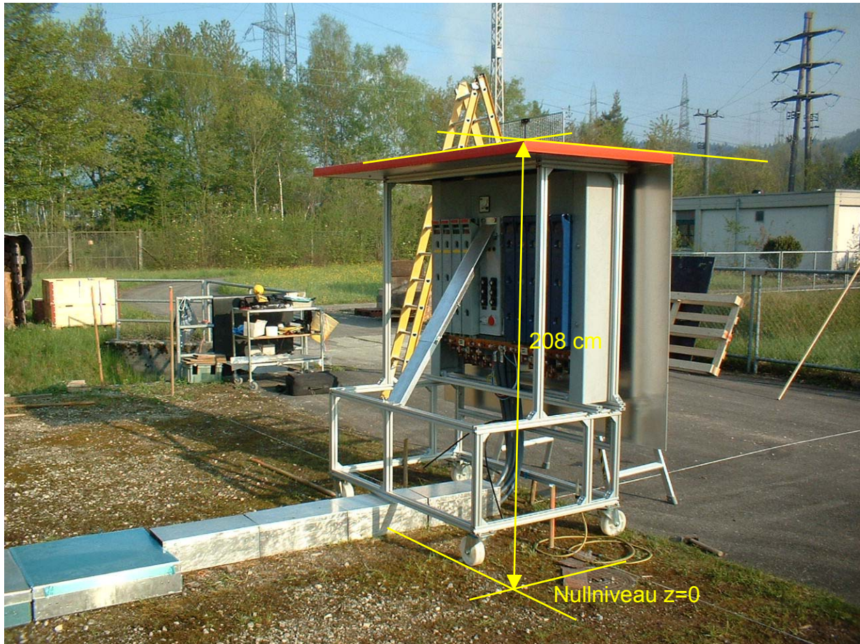
Figur 4.2: NS-Verteilung mit der PowerMan-Abschirmung
