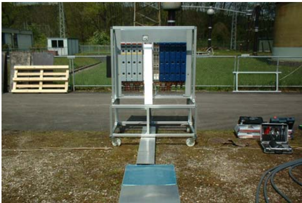
Figur 4.3: Verlegung der NS-Kabel:
