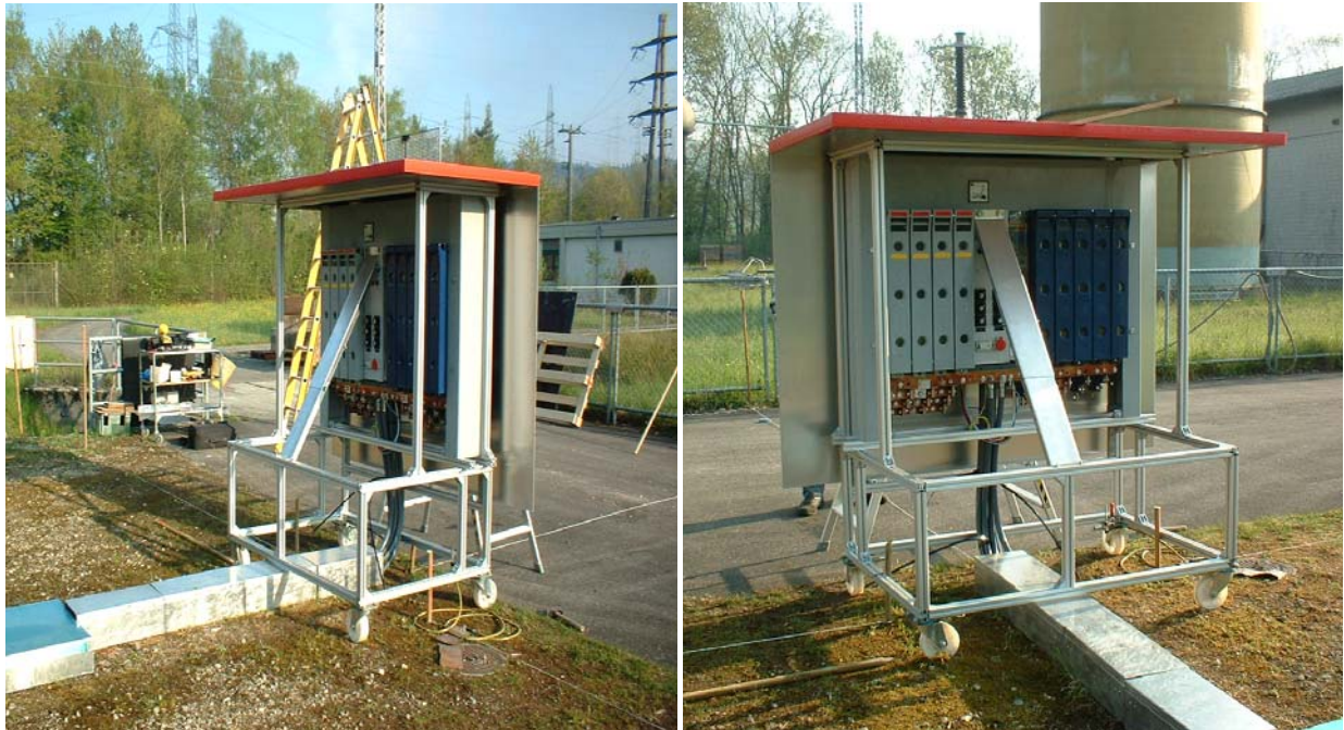
Figur 5.4: NS-Verteilung mit PowerMan-Abschirmung montiert mit 5 cm Abstand zwischen dem hinteren Rahmen und der Abschirmwand
