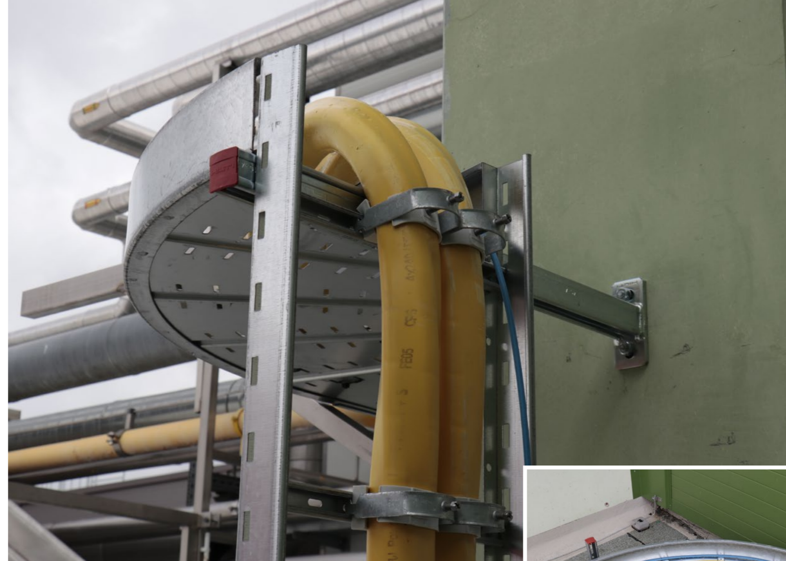
Wendig Steigzonen, rechtwinklige Mauerdurchbrüche und enge Radien sind kein Problem für das CFW PowerCable.
