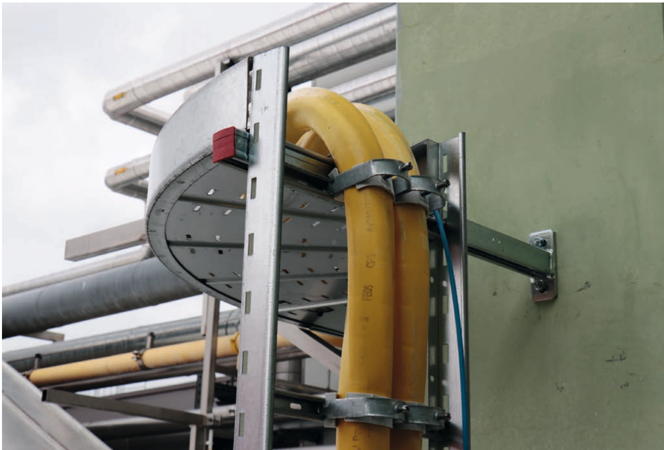
Wendig: Steigzonen, rechtwinklige Mauerdurchbrüche und enge Radien sind kein Problem für das CFW PowerCable.
